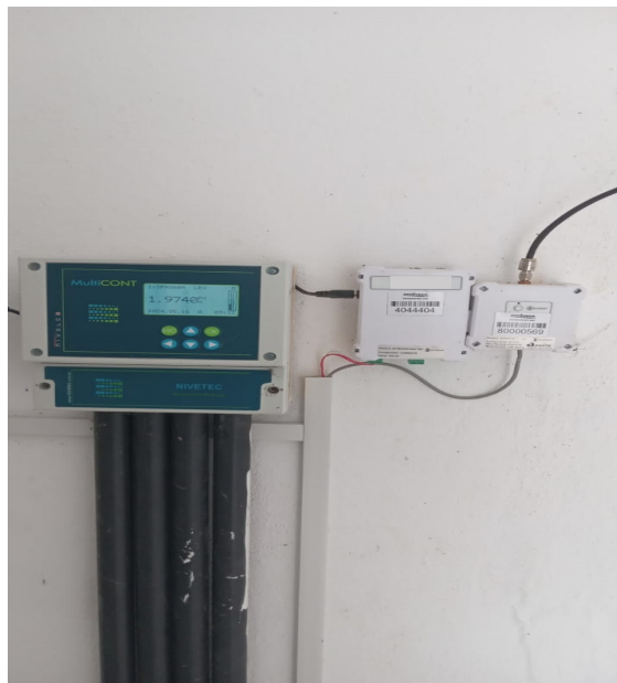
Figura 4: Equipamentos utilizados para a coleta e transmissão de dados realizados pela rede IoT/LoRa .
