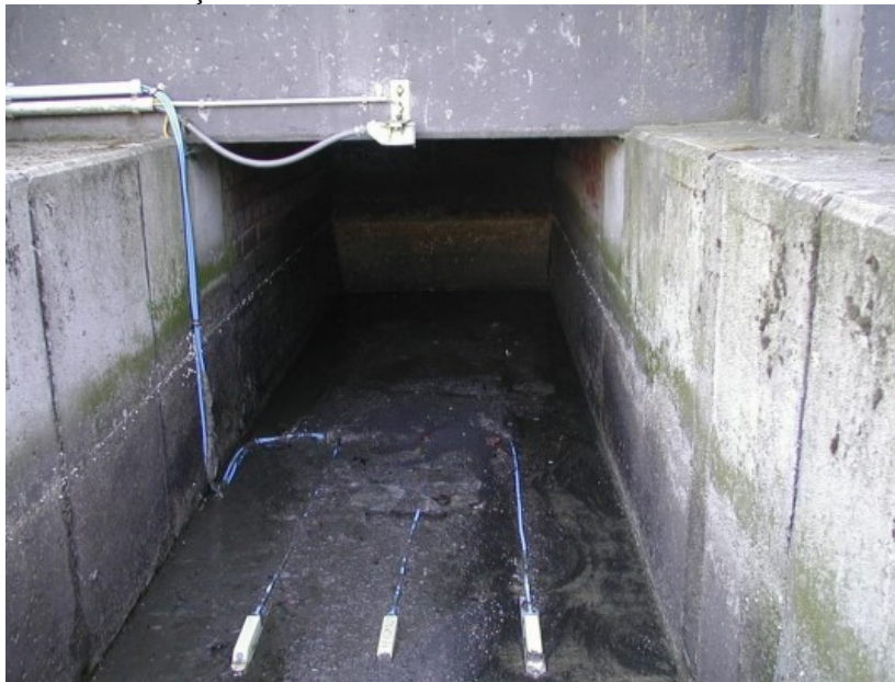
Foto 4 – Instalação Cross Correlation em canal de alta turbulência
