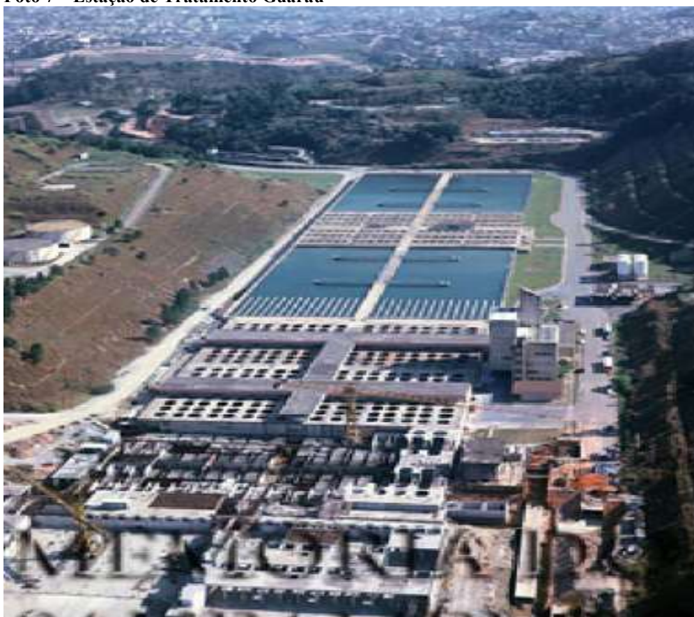
Foto 7 – Estação de Tratamento Guarau
