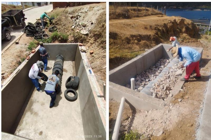
Figura 6: Construção de fossa agroecológica na Comunidade Quilombola Entremontes (Piranhas).
