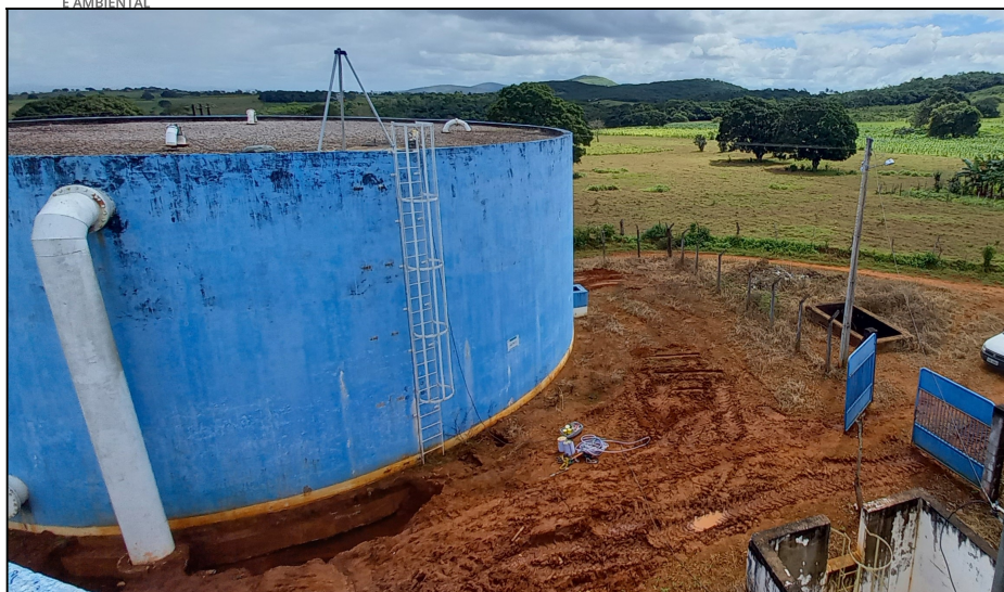
Figura 3 – Caixa de Passagem 1.
