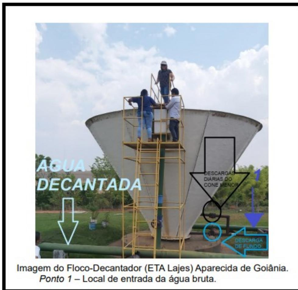
Figura 13- Flocó-Decantador Multicone.
