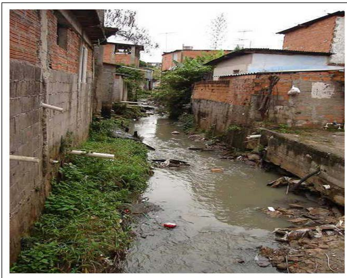
Figura 2: ausência de rede coletora de esgoto em área de periferia urbana
