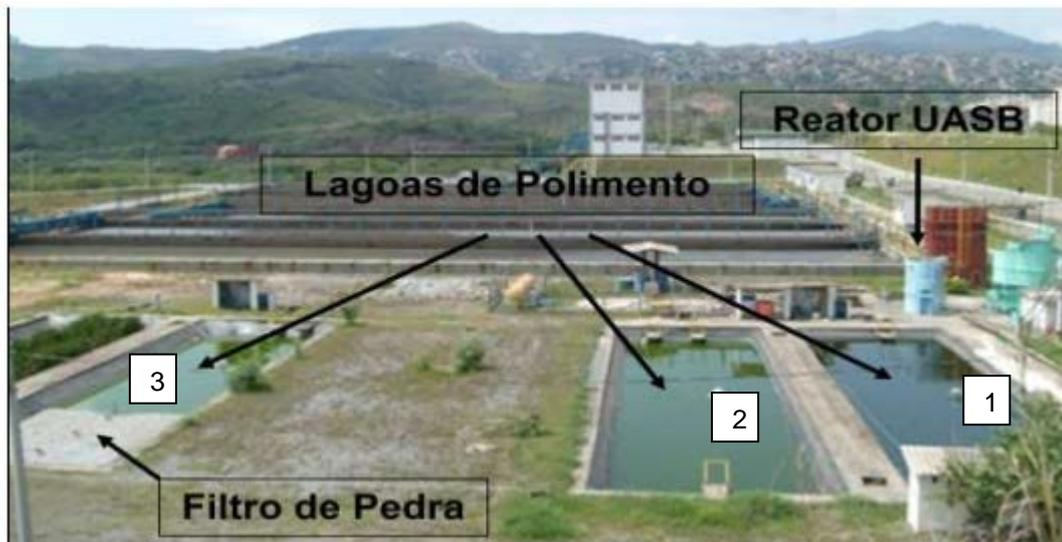
**Figura 1: Reator UASB e lagoas de polimento 1, 2 e 3.**
