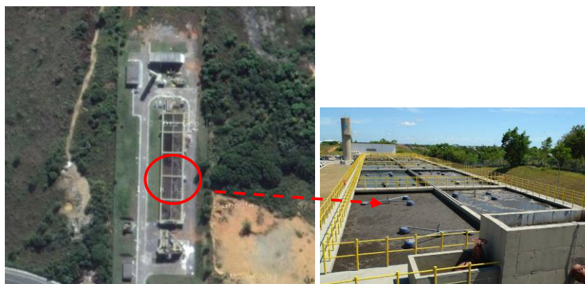
Figura05: Vista geral da ETE Manguinhos(Google Earth) e detalhe dos aeradores no tanque de aeração.
