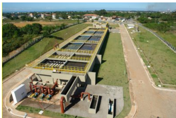
Figura04: Foto aérea da ETE Manguinhos. Fonte: CESAN.
