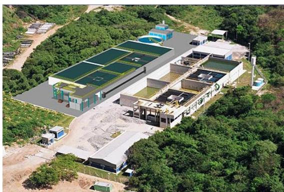
Figura 03: Foto aérea da ETE Mulembá/ duplicação. Fonte: http://www.saneamentoes.com.br/site/?target=vitoria
