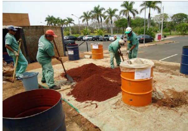
Figura 4: Preparação e mistura da terra contaminada com óleo mineral isolante para a compostagem.
