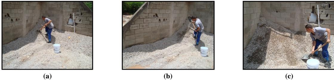
**Figura 1 – a) Formação de pilha de agregados tipo ARC. b) Homogeneização das amostras de agregados tipo ARC. c) Coleta amostra de campo de agregados tipo ARC.**
