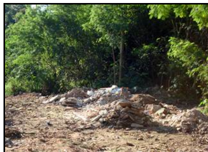
Figura 4: Descarte de RCD na APP próxima ao Córrego Santa Fé (Córdoba, 2010).
