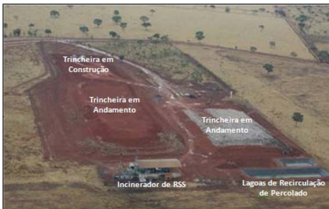
Figura 9: Imagem aérea do aterro sanitário de Cidade Ocidental.
