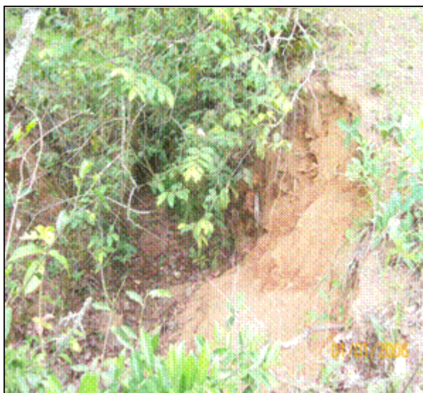
Figura 6: Erosão visualizada na Nascente 02.
