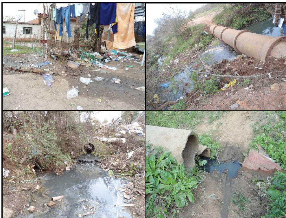
Figura 3. Pontos de lançamento inadequado do esgoto nos locais em estudo.
