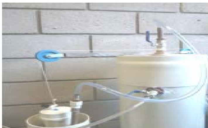
Fotografia 03: Gasômetro de cúpula flutuante acoplado ao reator UASB.
