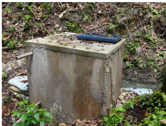
Figura 5: Caixa de tomada d'água em Areia
