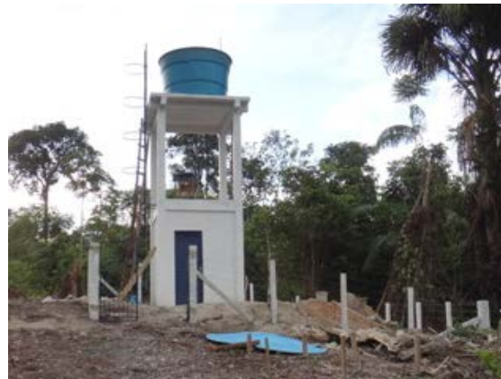
Figura 8: Reservatório e abrigo em Riozinho
