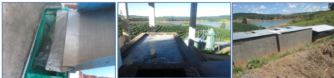
Figura 1 (a) Peneira estática, (b) caixa de gordura, (c) Reator ABR seguido de filtro anaeróbio.
