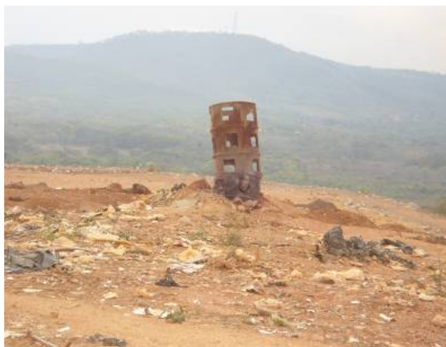
Figura 11. Captação dos gases provenientes da decomposição do lixo. Fonte: Fernando Nunes Belém et al.
