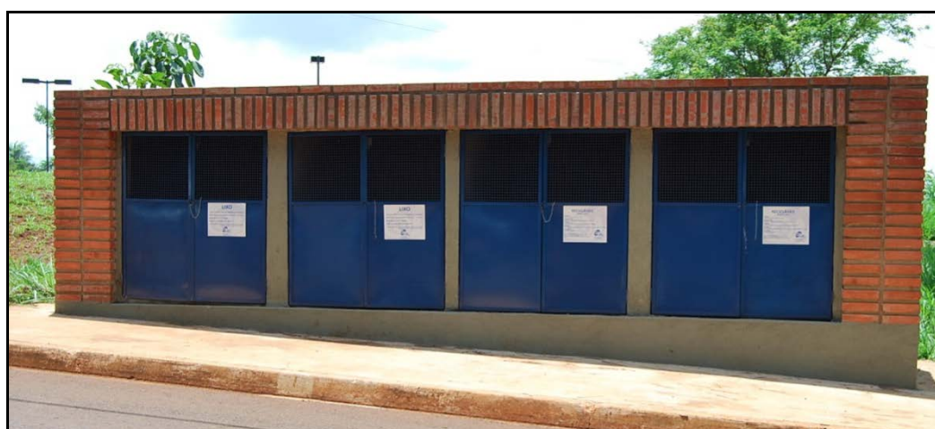
Figura 1 – Abrigos de alvenaria para armazenamento dos resíduos gerados no Campus da USP de Ribeirão Preto
