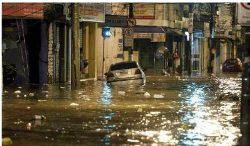
Figura 1 - Alagamento na Praça da Bandeira (Arquivo Pessoal, 2013).
