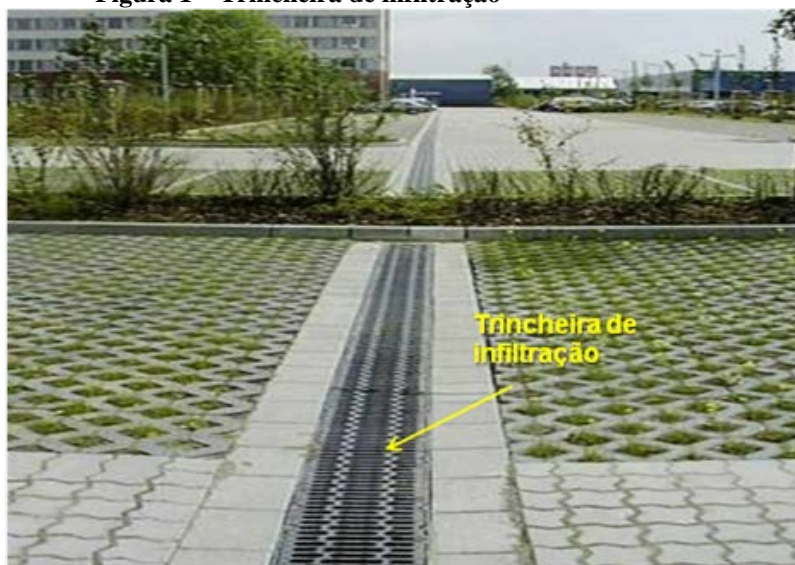
Figura 1 – Trincheira de infiltração
