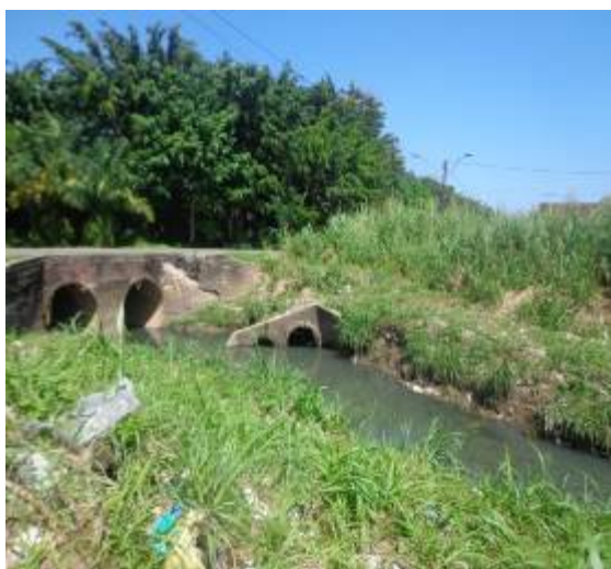
Figuras 06 e 07 – Má conservação das estruturas hidráulicas e entupimento das galerias de drenagem por lixo.
