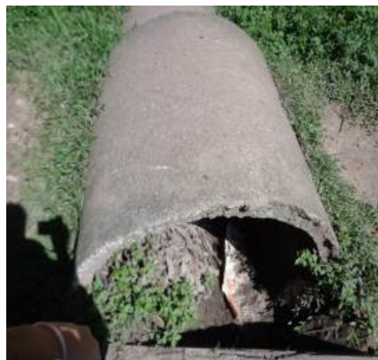
Figuras 06 e 07 – Má conservação das estruturas hidráulicas e entupimento das galerias de drenagem por lixo.
