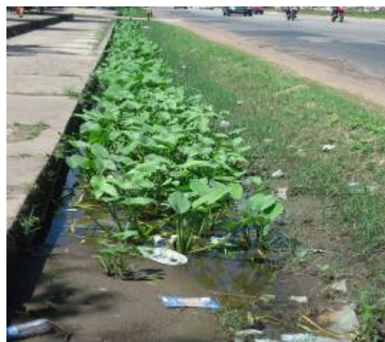
Figura 09 – Alagamento na avenida Augusto Montenegro e identificação de macrófitas e assoreamento no canal da mesma
