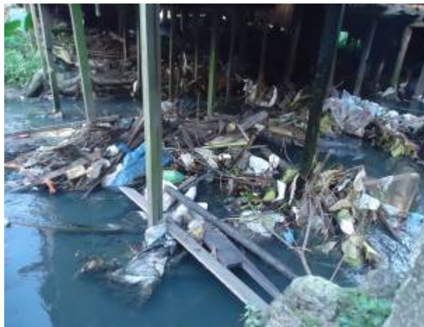
Figura 08 – Estrangulamento da seção do igarapé por resíduos
