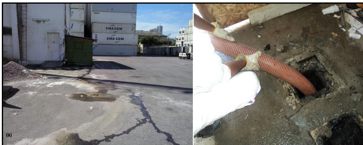
Figura 02: Efluentes sanitários (a) escoando no piso após transbordamento do sistema de fossa/sumidouro (b) esgotamento do sistema fossa/sumidouro por empresa licenciada
