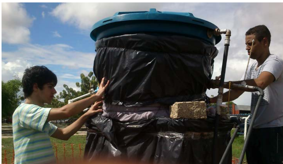
Figura 3 – Reservatório com revestimento térmico.
