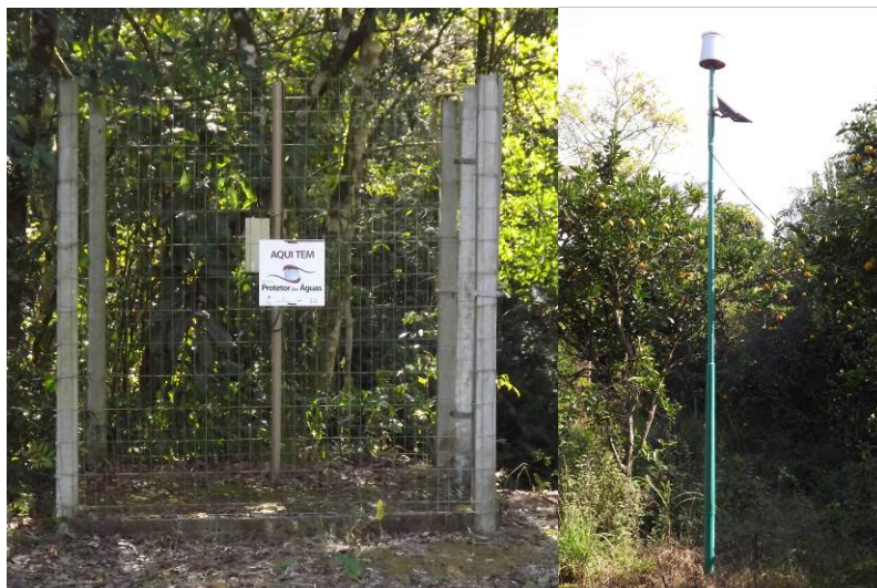
Figura 3- Estação fluviométrica instalada as margens do Arroio Andréas
