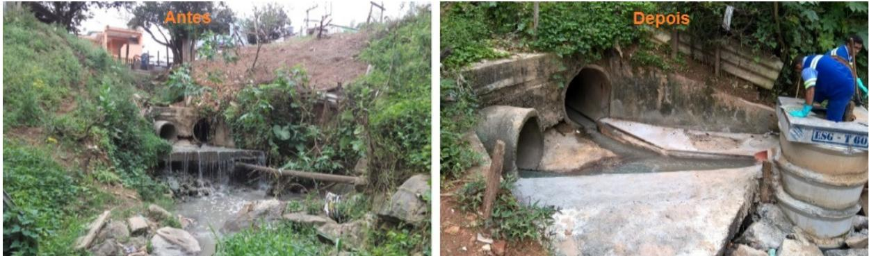
**Figura 05:** cenário antes x depois da instalação da válvula de captação de esgoto no ponto 02. **Fonte:** própria.
