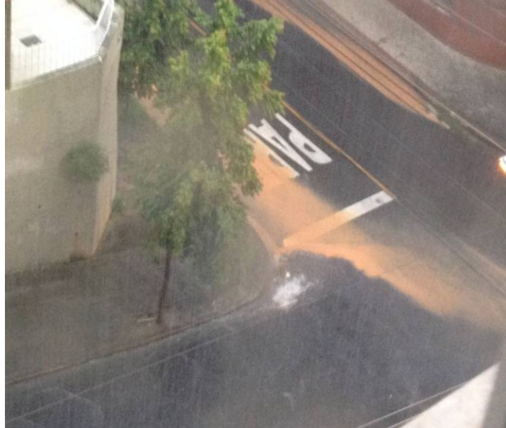
Figura 7 - Comportamento da Lâmina d'Água (em Planta) na Sarjeta e Boca de Lobo em Ponto Baixo de Via.
