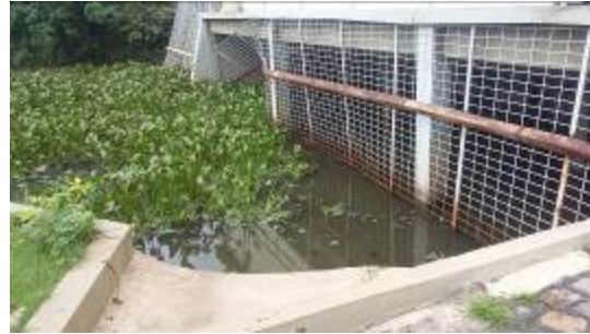
Figura 14. Grades de proteção às bombas danificadas devido à grande quantidade de agiapés no canal. Fonte: Autor.
