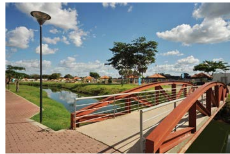
Figura 5. Área após intervenção do PLN – 1ª etapa.
