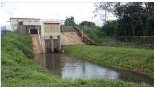
Figura 16. Estação elevatória da Av. Boa Esperança. Fonte: Autor.
