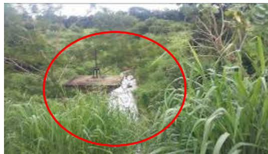
Figura 19. Presença de espuma na saída do canal de drenagem da Estação elevatória do dique do barro Mocambinho. Fonte: Autor.
