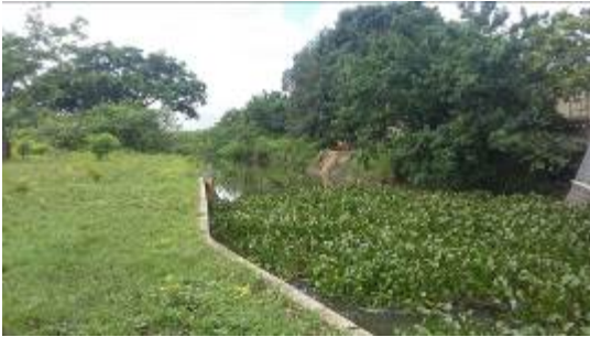
Figura 13. Agiapés do canal da estação elevatória de Boa Esperança. Fonte: Autor.
