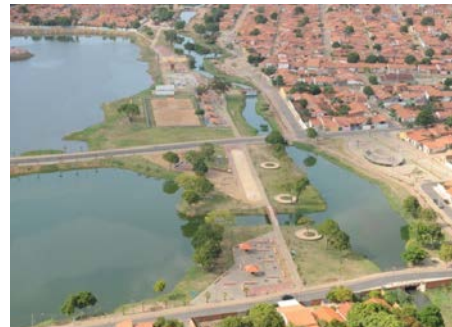
Figura 3. Área após intervenção do PLN – 1ª etapa.
