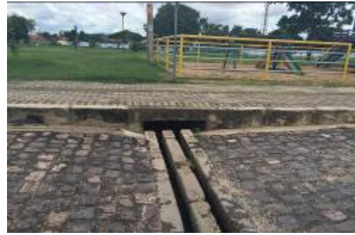
Figura 7. Boca de lobo sem o gradeamento. Fonte: Autor.
