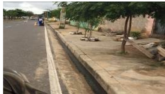
Figura 12. Sarjetas drenando esgoto sanitário doméstico. Fonte: Autor.
