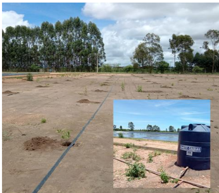
Figura 8: Sistema de gotejamento da ETE II para irrigação de mudas nativas com efluente tratado.
