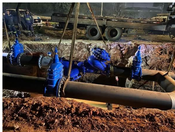
Figura 7: Instalação do barrilete VRP Dutra
