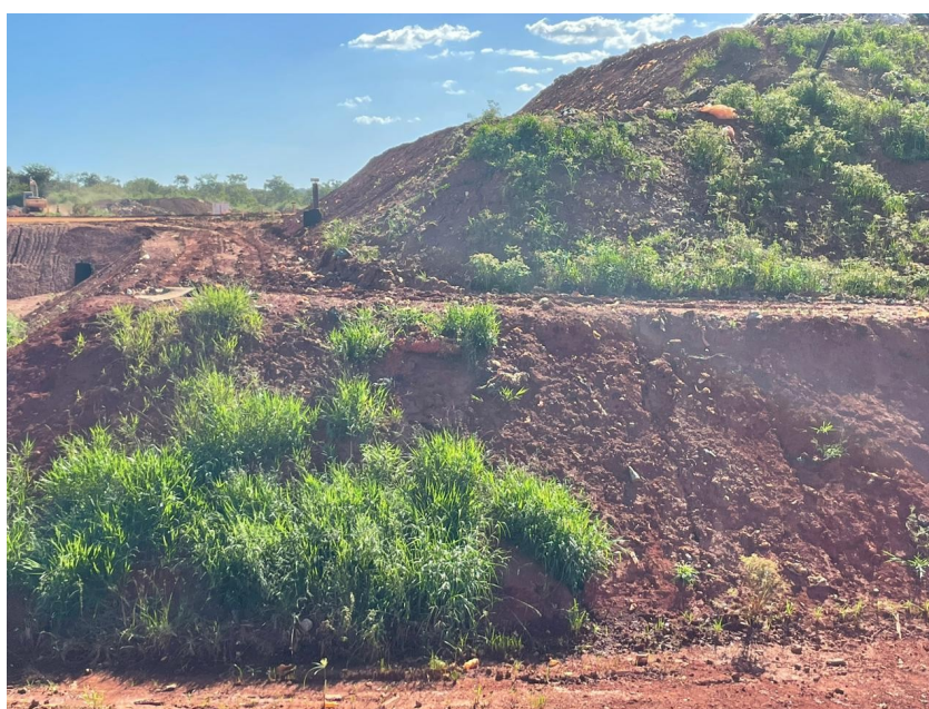
Figura 4: Talude com recobrimento de LETA apresentando o crescimento de gramíneas.
