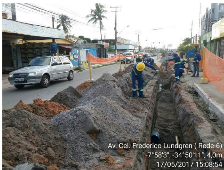
Figura 3 - Obra de assentamento de nova rede de distribuição
