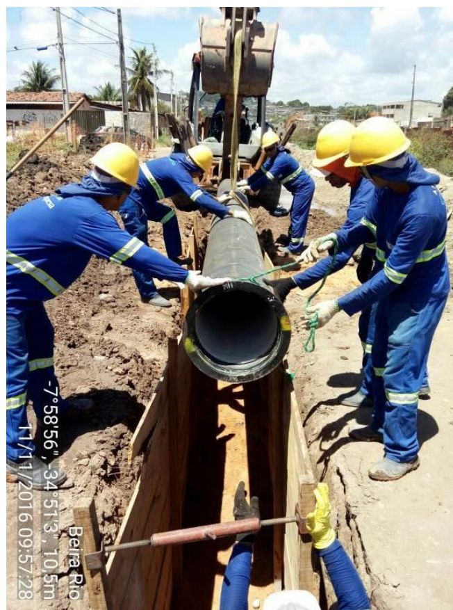
Figura 4 - Obra de assentamento de nova rede de adução de água
