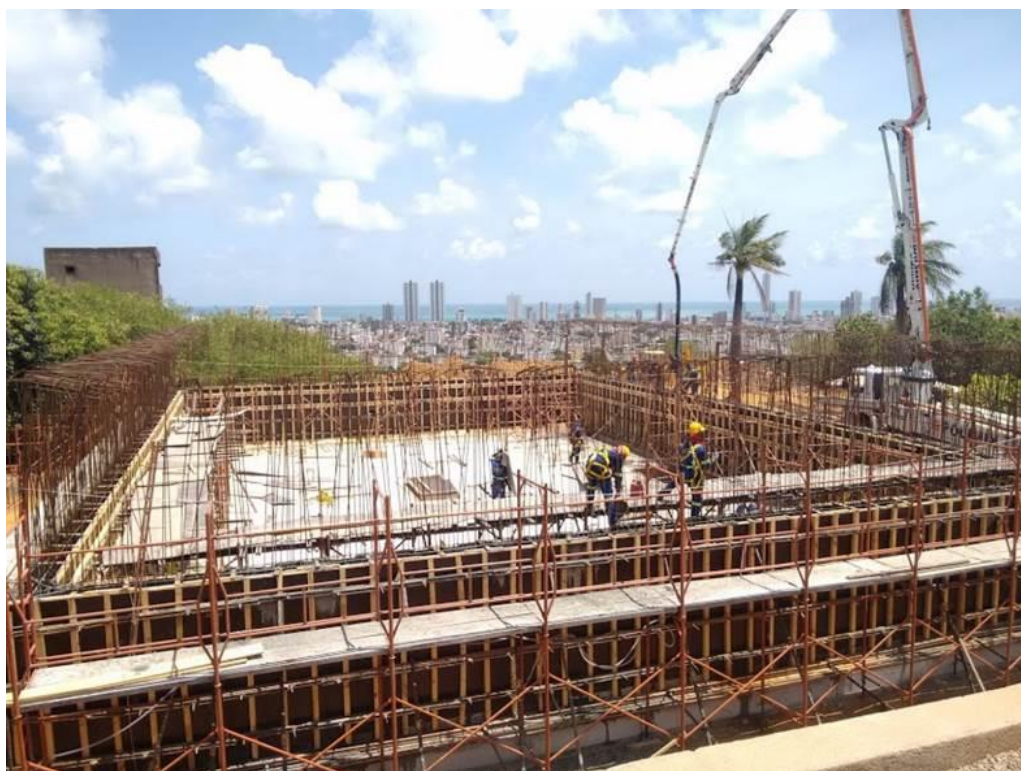
Figura 5 - Construção da laje de um dos reservatórios
