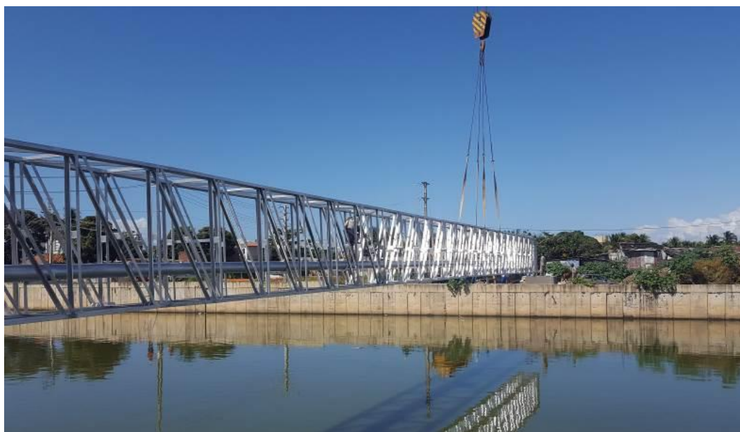
Figura 7 - Travessia apoiada em treliça metálica
