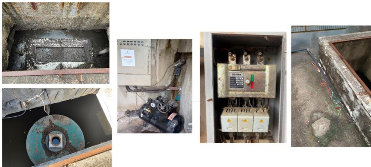
Figura 1: imagens da ETE1 antes da reforma, com as estruturas muito comprometidas.
