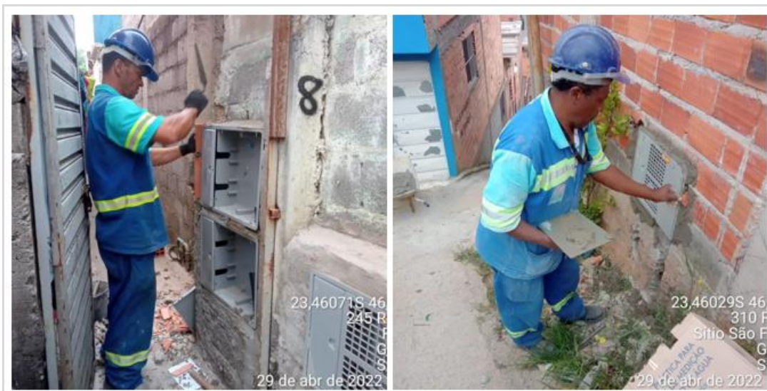
Figura 2: Instalação de caixa uma. Fonte: Autores.
