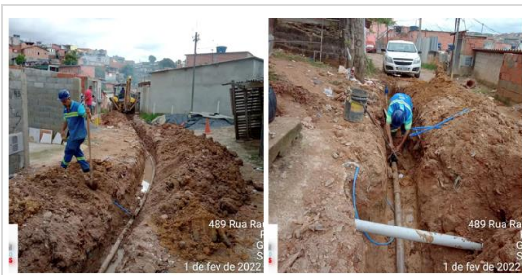
Figura 3: Assentamento de novas redes de abastecimento de água. Fonte: Autores.
