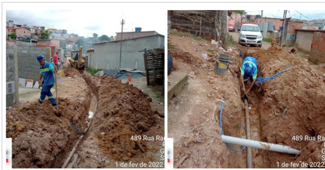
Figura 6 - Assentamento de novas redes de abastecimento de água Fonte: Autores.
