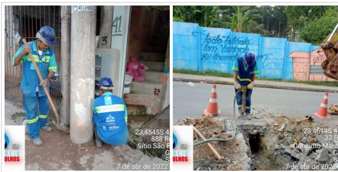
Figura 5 - Execução de novas ligações para abastecimento de água Fonte: Autores.
