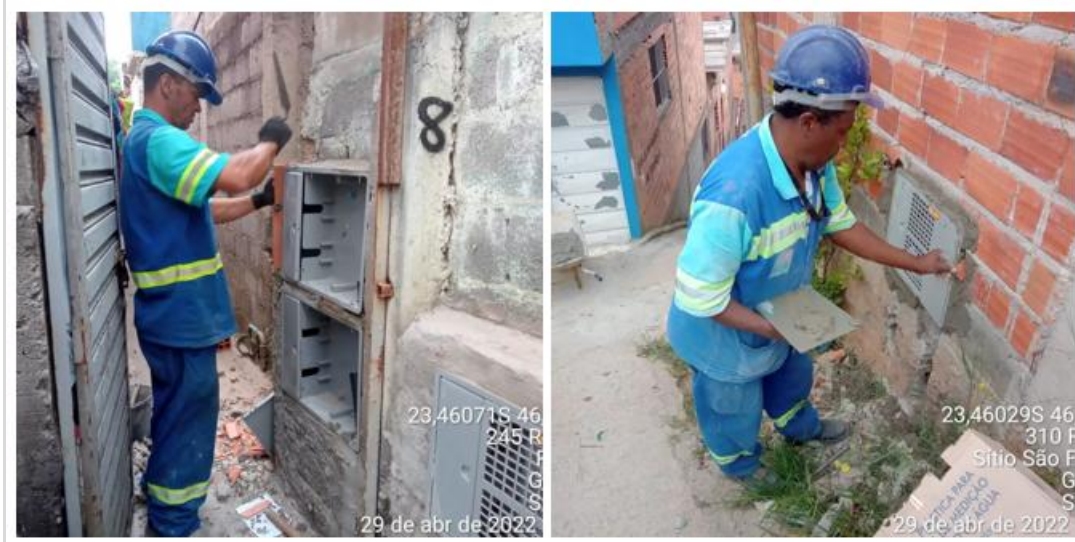
Figura 4 - Instalação de caixas UMA Fonte: Autores.
