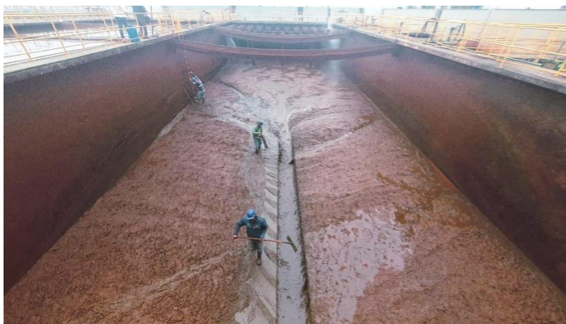
Figura 1: Limpeza do Decantador da Estação de Tratamento de água Fonte: Arquivo Pessoal (2024)
