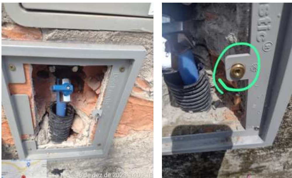
Figura 5 – Quebras na região do fecho que motivaram o desenvolvimento de nova solução
