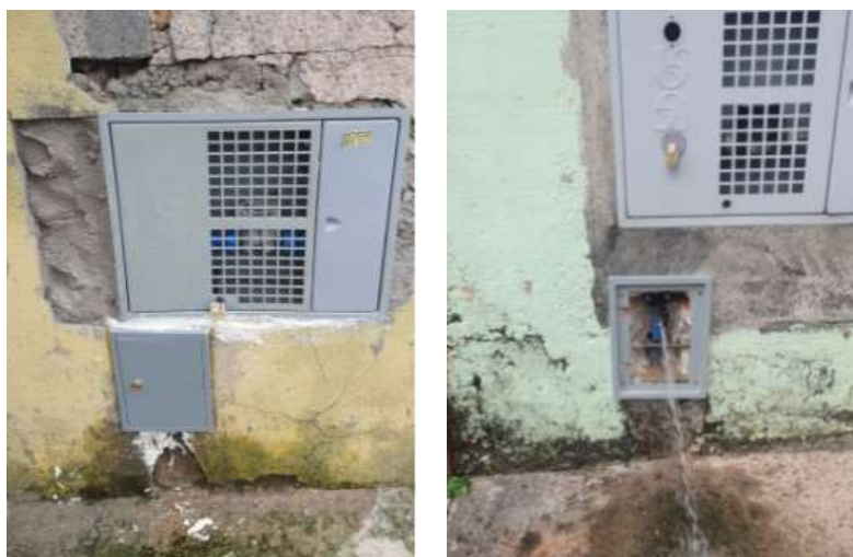
Figura 3 – Exemplos de situações em que a qualidade dos muros era baixa, dificultando a instalação das UCQAs
