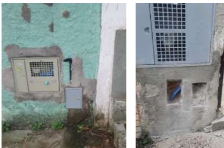
Figura 4 – Exemplos de situações em que o posicionamento da UCQA não pôde ser realizado conforme a diretriz de localização prevista na NTS 363
