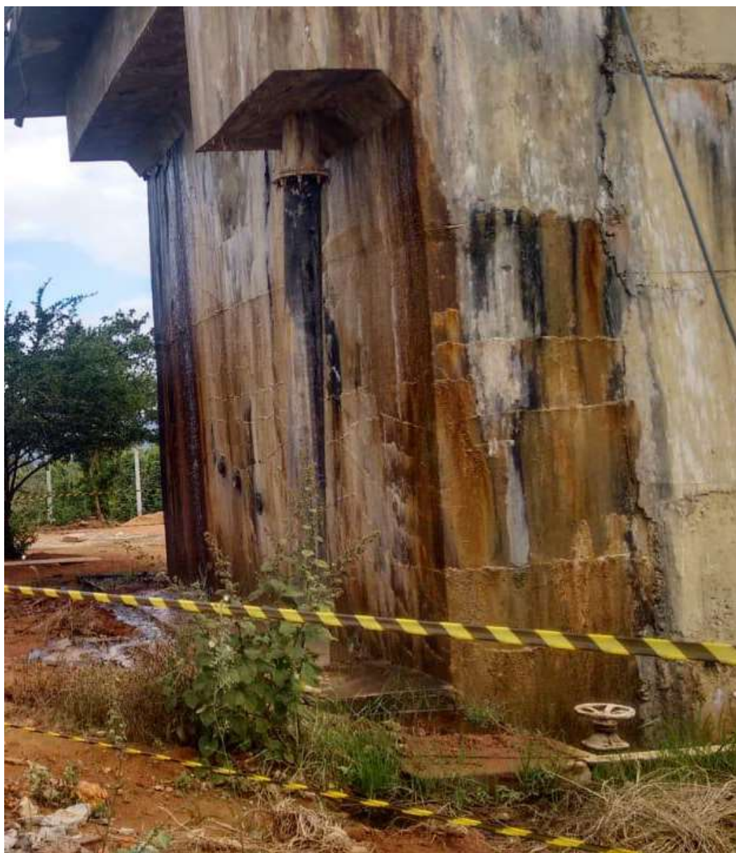
Figura 1: Estrutura do floculador e decantador existente em colapso, localizada na ETA Iramaia.
