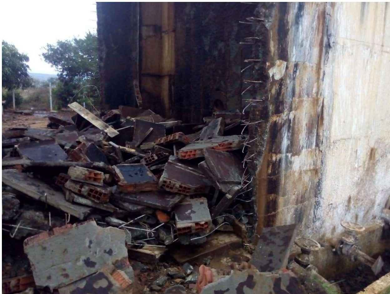
Figura 1: Estrutura do floculador e decantador existente em colapso, localizada na ETA Iramaia.
