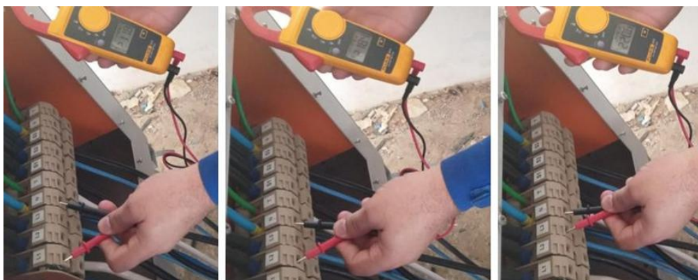
Figura 9: Medições na entrada o Regulador Produção própria
