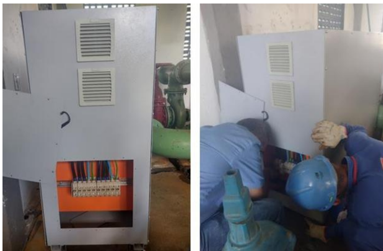
Figura 8: Instalação do regulador BT/BT Produção própria
