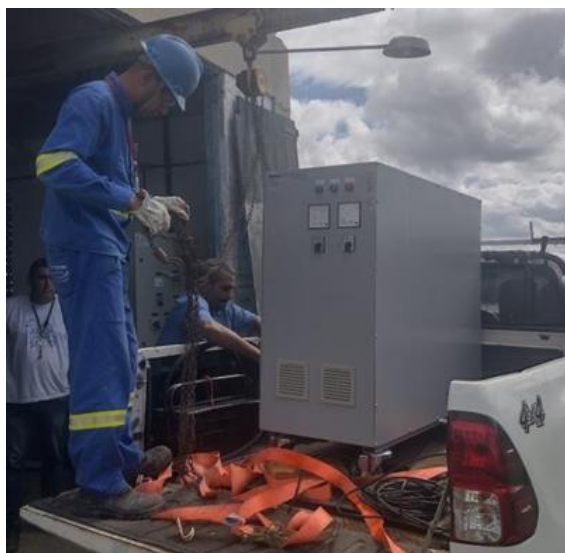
Figura 7: Transporte do regulador BT/BT Produção própria
