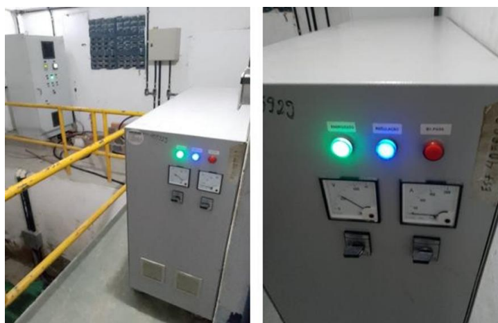
Figura 11: Regulador BT/BT (P1 Rio Real) Produção própria
