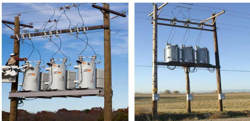
Figura 4: Regulador de tensão instalado na rede de distribuição https://meshengenharia.com/2023/12/19/regulador-de-tensao/
