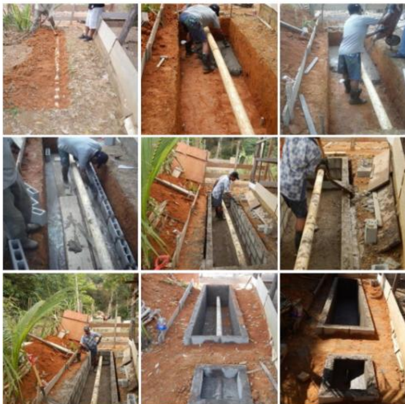
Figura 2: Registro fotográfico da construção do Sistema Alagado Construído.
