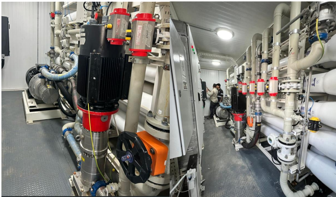
Figura 7: Detalhe da bomba de alta pressão tipo pistão axial, dispositivo de recuperação de energia (ERD) isobárico e vista geral interna do módulo SWRO, evidenciando o layout otimizado dos módulos de membranas e tubulações em aço Super Duplex – Fonte: Autores.
