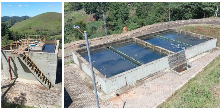
Figura 6: Da esquerda para a direita: (i) reator UASB; (ii) filtro anaeróbio. Pedro Teixeira – MG.
