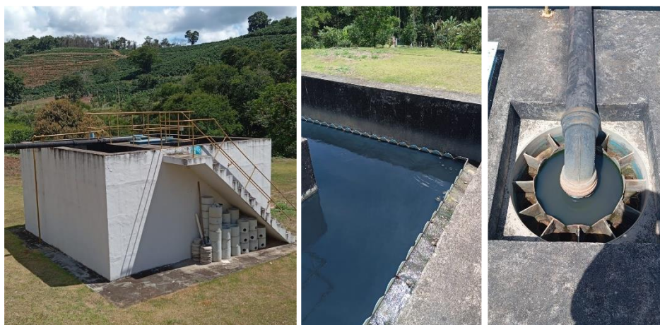
Figura 4: Da esquerda para a direita: (i) reator UASB; (ii) área aberta do decantador; (iii) caixa distribuidora de esgoto no reator UASB. Vermelho Novo-MG.
