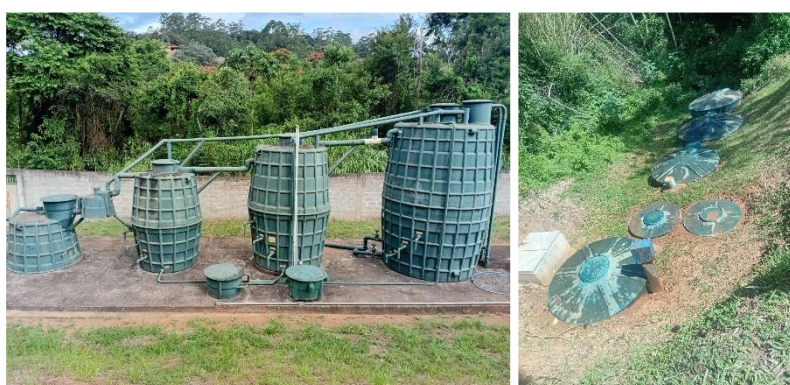
Figura 5: Da esquerda para a direita: (i) reator UASB + lodos ativados + desinfecção; (ii) tanque séptico + filtro anaeróbio. Viçosa – MG.
