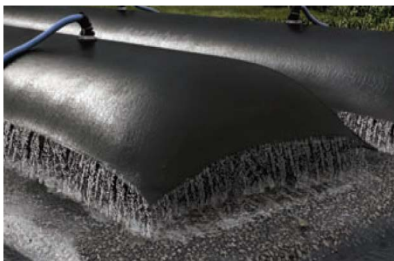
Figura 1 – Bag de Geotecido durante o desaguamento.
