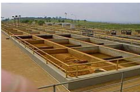
Figura1– Esquema e fotos de unidades de floculação com chicanas e escoamento vertical ascendente e descendente
