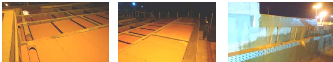
Figura 2 – Transbordamento da unidade de floculação de chicanas com escoamento vertical
