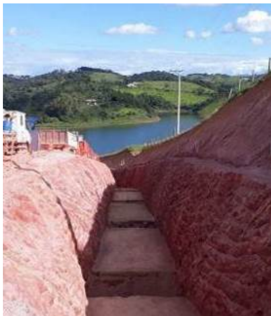
Figura 23: Vala para assentamento de tubo
