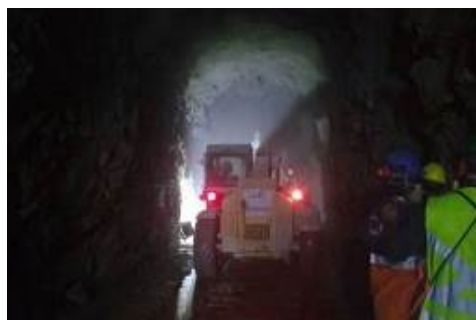
Figura 26: Execução de concreto projetado no túnel
