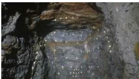
Figura 25: Frente de escavação com plano de fogo marcado antes do início da perfuração
