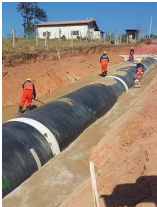
Figura 24: Vala com tubo assentado e envoltória em execução
