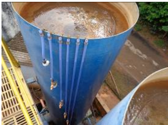
(a) Piezômetros instalados na ETA estudada
