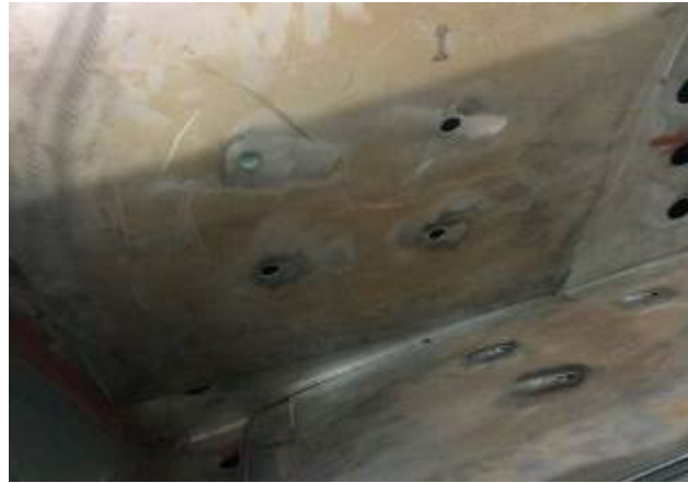
(a) Placa utilizada para aferição dos C_d em canal de alvenaria
