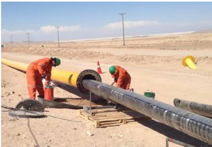
Foto 03 – Exemplo de instalação.
