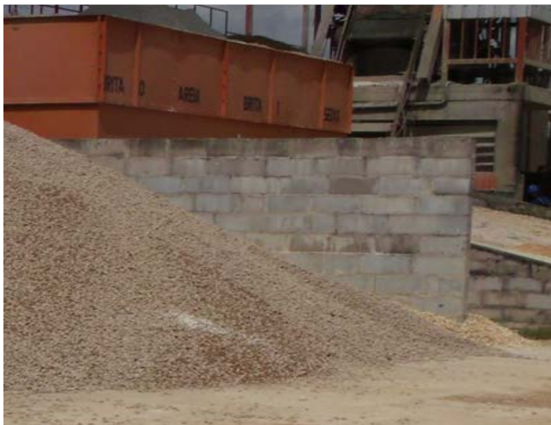
Figura 04: Resíduo de concreto britado
