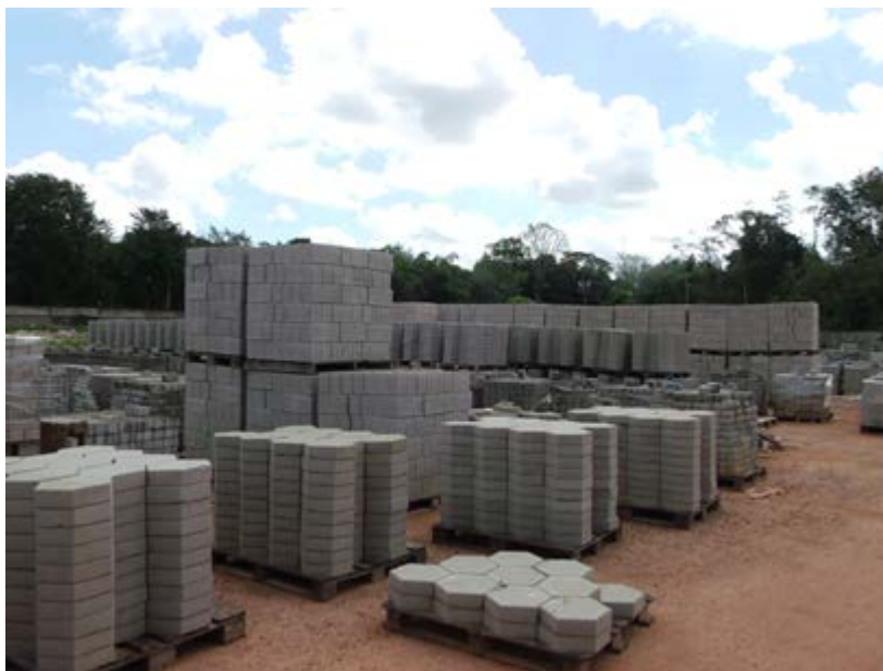
Figura 8: Estocagem dos bloquetes de concreto
