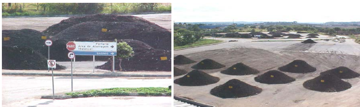
Fig. 2 – vistas gerais do pátio de compostagem na área do aterro da BR-040, em Belo Horizonte.
