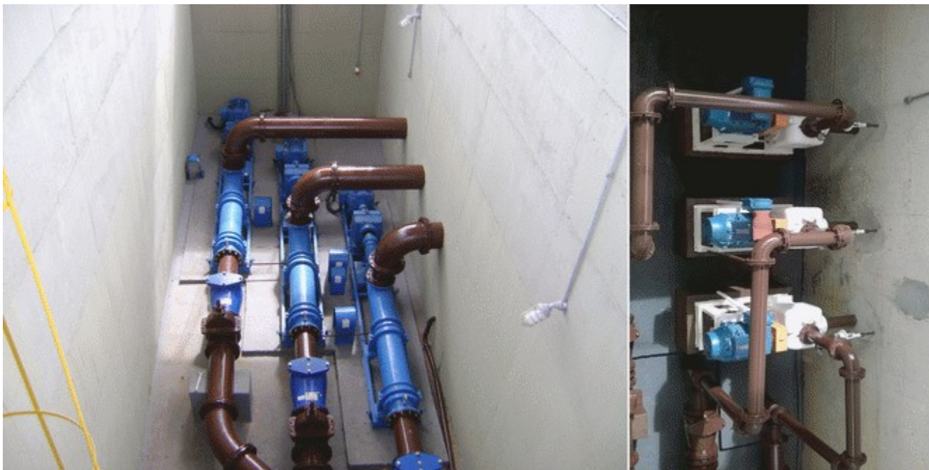
Foto 1 – EEE Itaberaí bomba Helicoidal (esq) e Re-autoescorvante (dir)
